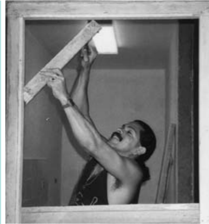
Der Umbau eines baufälligen Einfamilienhauses in ein funktionelles Labor erfordert Planung und Präzisionsarbeit
