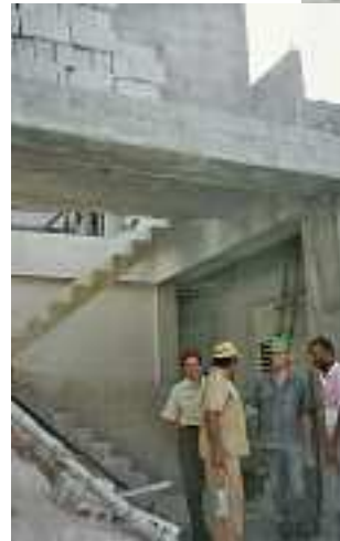
Rohbau für das MNT-Zentrum mitten in Bayamo
