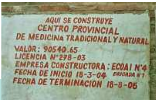
Plakette an der Baustelle in Bayamo. «Hier wird das Provinzzentrum für Medicina Tradicional y Natural gebaut».
